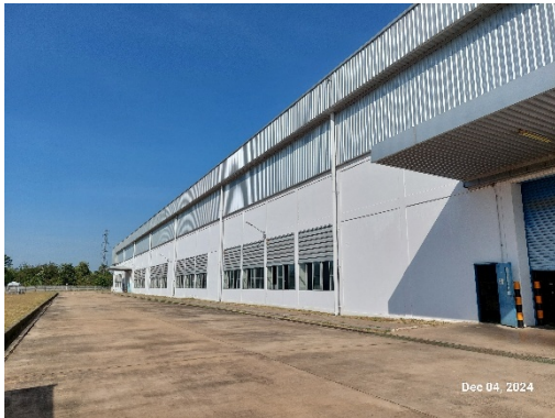
รูปที่ 2-4 บริเวณภายนอกอาคารปฏิบัติงานที่มีกำแพงอาคารเป็นกำแพงกันเสียง
