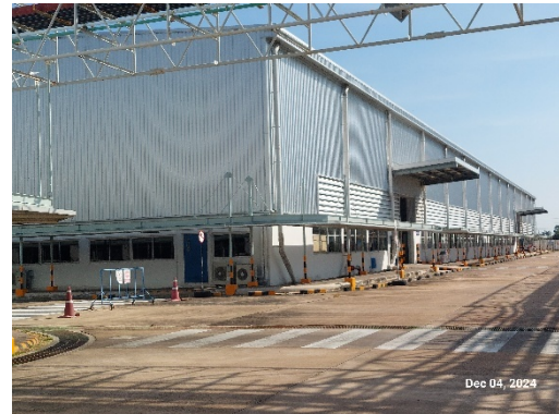
รูปที่ 2-4 บริเวณภายนอกอาคารปฏิบัติงานที่มีกำแพงอาคารเป็นกำแพงกันเสียง
