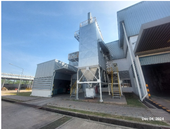
รูปที่ 2-1 ระบบดักฝุ่นแบบถุงกรอง
